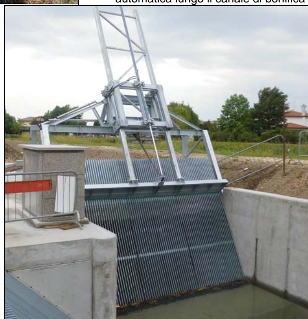
Punto di inserimento della sgrigliatore automatico ed esempio dell'attrezzatura che verrà inserita sul canale al fine di evitare che materiali e corpi estranei possano entrare nella centrale di pompaggio delle acque irrigue
